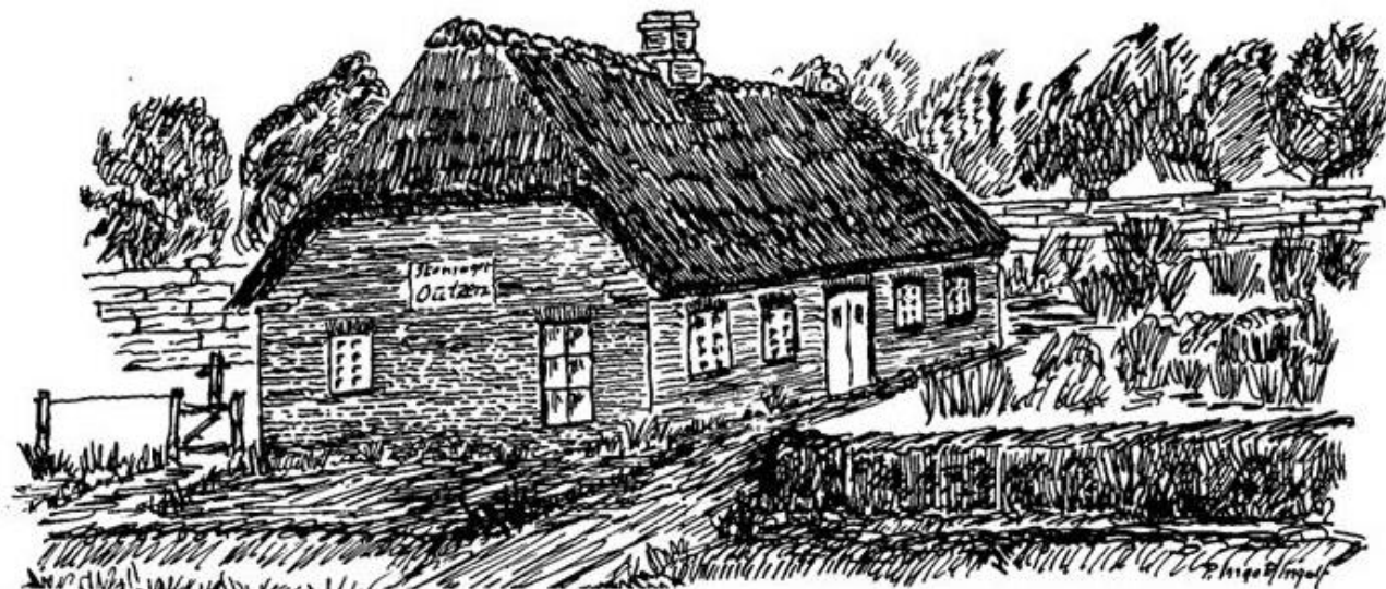
Outzens Hus med skomagerværksted bygget 1852 var et lille stråtækt hus, som lå, hvor Centret er i dag. Det var anlagt ved den nye landevej gennem Skjern med vid udsigt i alle retninger. Tegnet af Peter Ingolf Christensen.
